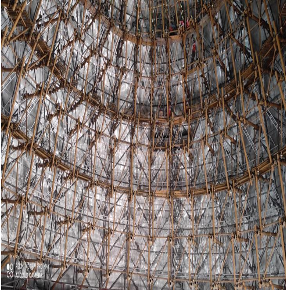
SS Sub-frame erection
